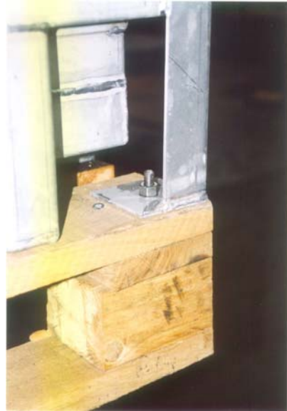
Particolare coperchio superiore e fissaggio Particular upper cap and anchoring
